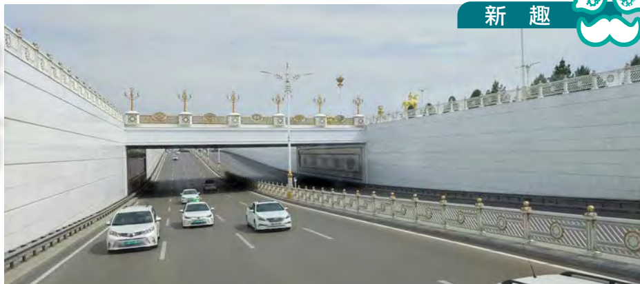
建築、欄杆、燈柱、巴士，都是白色和金色。
